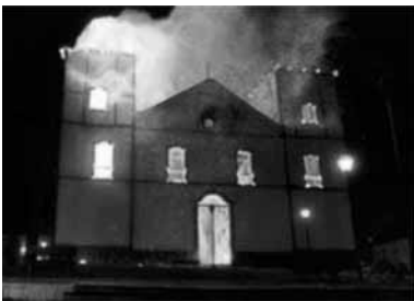
D. 2002: Incêndio, com destruição parcial do edifício e ruína dos elementos artísticos.
