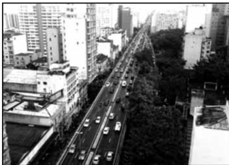
Região da Praça Marechal Deodoro em 2009, depois da construção do Minhocão.
