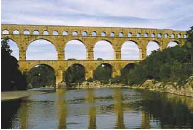
(Aquaduto romano Pont-du-Gard , sul da França.)
