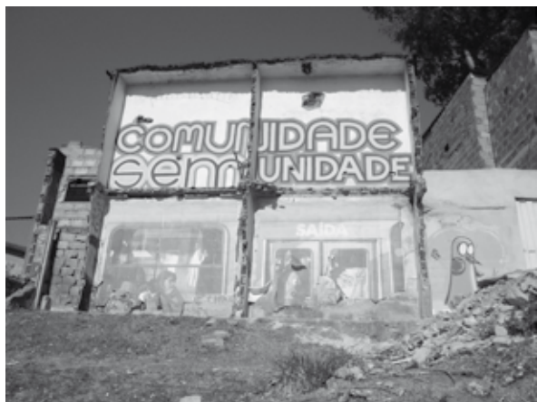
Foto da Equipe Elaboradora da Prova, set. 2009 Avenida Antônio Carlos, Cachoeirinha, Belo Horizonte/MG.
