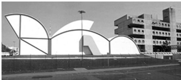
Foto 1: Vista atual do hospital da Rede Sarah em Brasília, e a edificação original ao fundo
