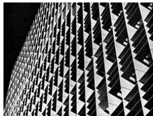
Figura II: fachada com brise-soleil
